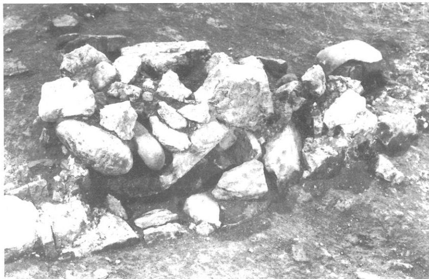
Fig. 28 - Trento, palazzo Tabarelli 1981. Particolare della struttura muraria romana con sutura a secco in materiali inerti di recupero.
