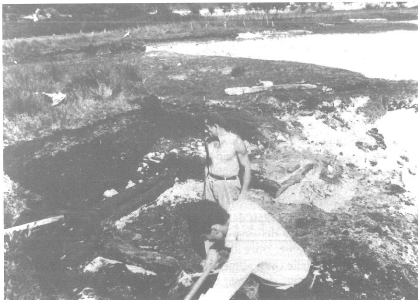
Fig. 19 - Molina di Ledro, loc. «Volta de Besta» 1958. Accanto agli operai è chiaramente visibile la struttura quadrangolare in pali a tutto tondo incrociantsi ad incastro.
