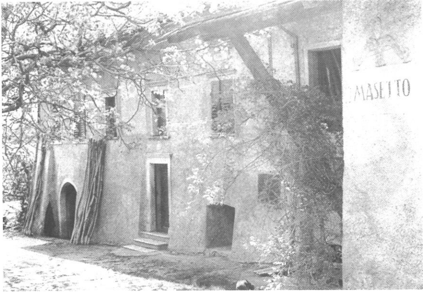
Fig. 26 - Tipo di elemento strutturale architettonico comune nelle vecchie costruzioni trentine.
