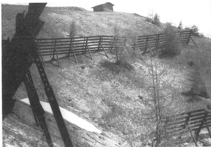
Fig. 12 - Paravalanghe costituiti da profilati metallici. Si notano piccoli larici che, una volta cresciuti avranno la funzione svolta ora dai paravalanghe, dei quali non viene effettuata alcuna manutenzione.
