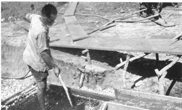
Fig. 15 - Griglia del primo «sluice» (= canale) per il lavaggio dell'alluvione aurifera. Sciacchisò (1940).
