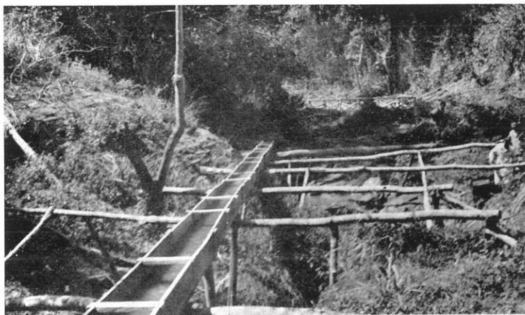
Fig. 16 - Canalizzazione d'acqua per i primi «sluices» di lavaggio dell'alluvione aurifera. Baddachessa (1940).
