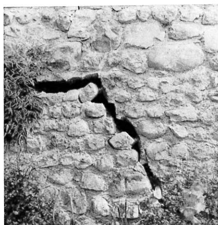
Foto 2 - Lesione beante nel muro perimetrale sovrastante il Rio della Paglia. (Foto A. Fuganti)
