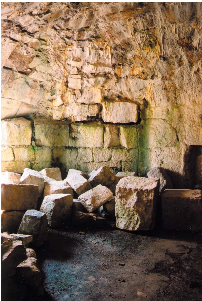
Fig. 3 - Ruderi . Interno di Forte Corno a Praso (foto Fabio Campolongo, 2004), Soprintendenza Beni culturali, Trento.
