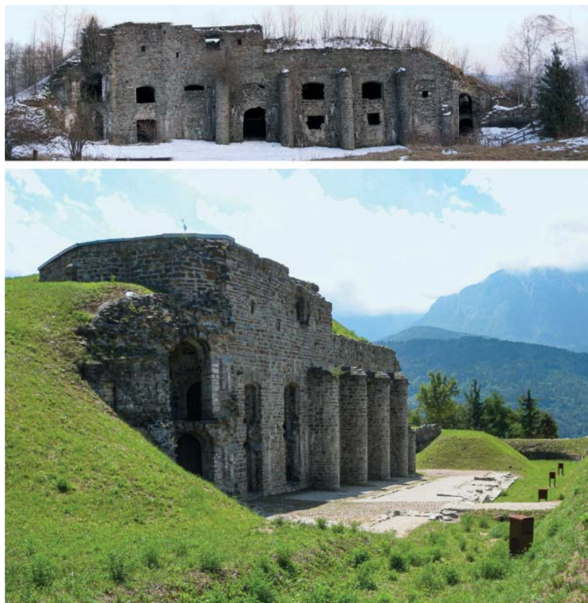
Fig. 6 - Forte Tenna . Prima e dopo il restauro (Cinza Broll, 2005, foto superiore; Fabio Campolongo, 2018, foto inferiore), Soprintendenza Beni culturali, Trento.
