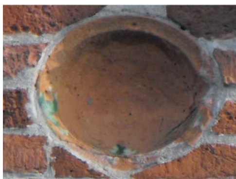
Fig. 4 - Belfiore, Madonna della Stra', facciata, bacino al colmo della facciata.
