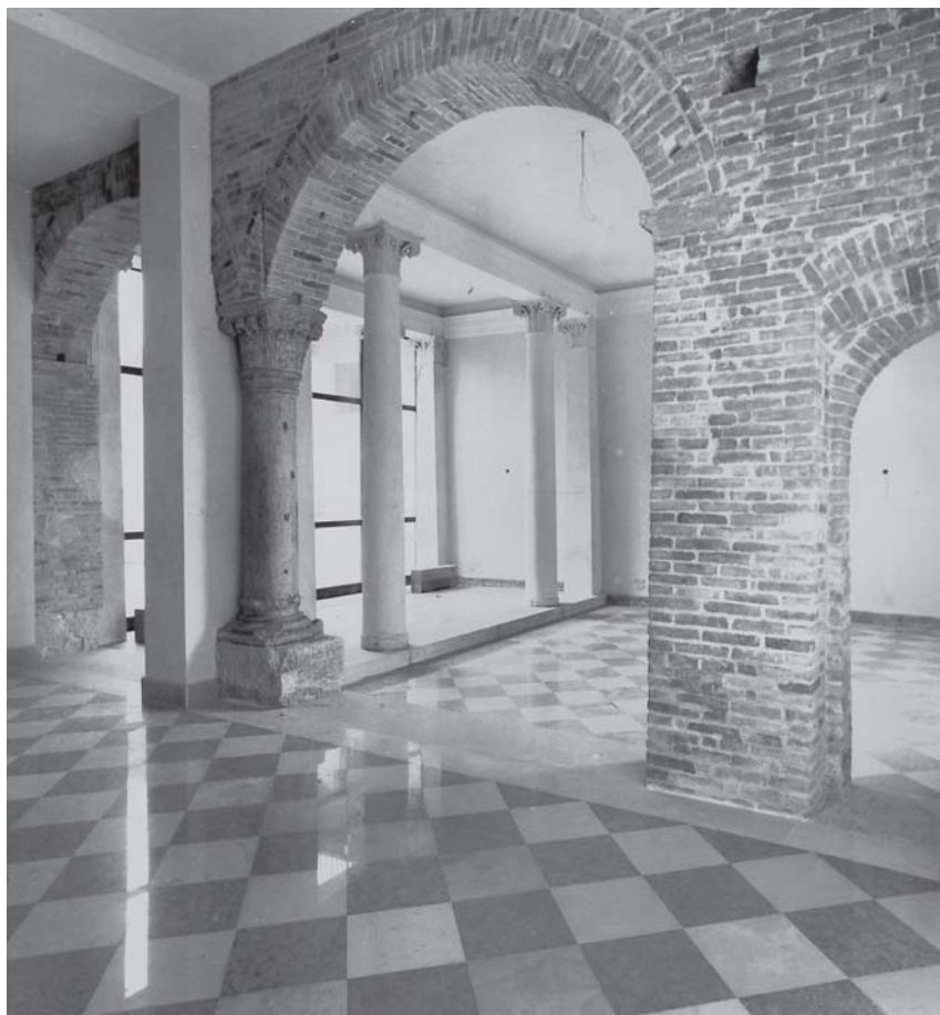
Casa Da sacco, piano terreno su via Adua, strutture trecentesche riapparse all'interno della casa.
