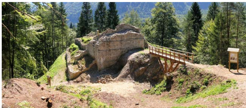
Fig. 7 - Il piccolo castello di Sacuidic, come si presenta oggi, dopo le indagini archeologiche e i lavori di consolidamento, integrazione e valorizzazione.
