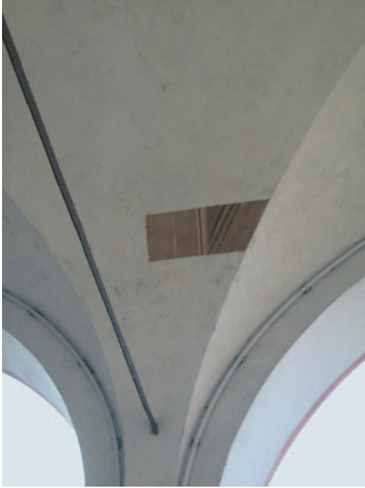
Fig. 19 - Pennacchio della volta tra la quindicesima e la sedicesima lunetta. Particolare di un tassello con traccia di decorazioni a finta architettura.
