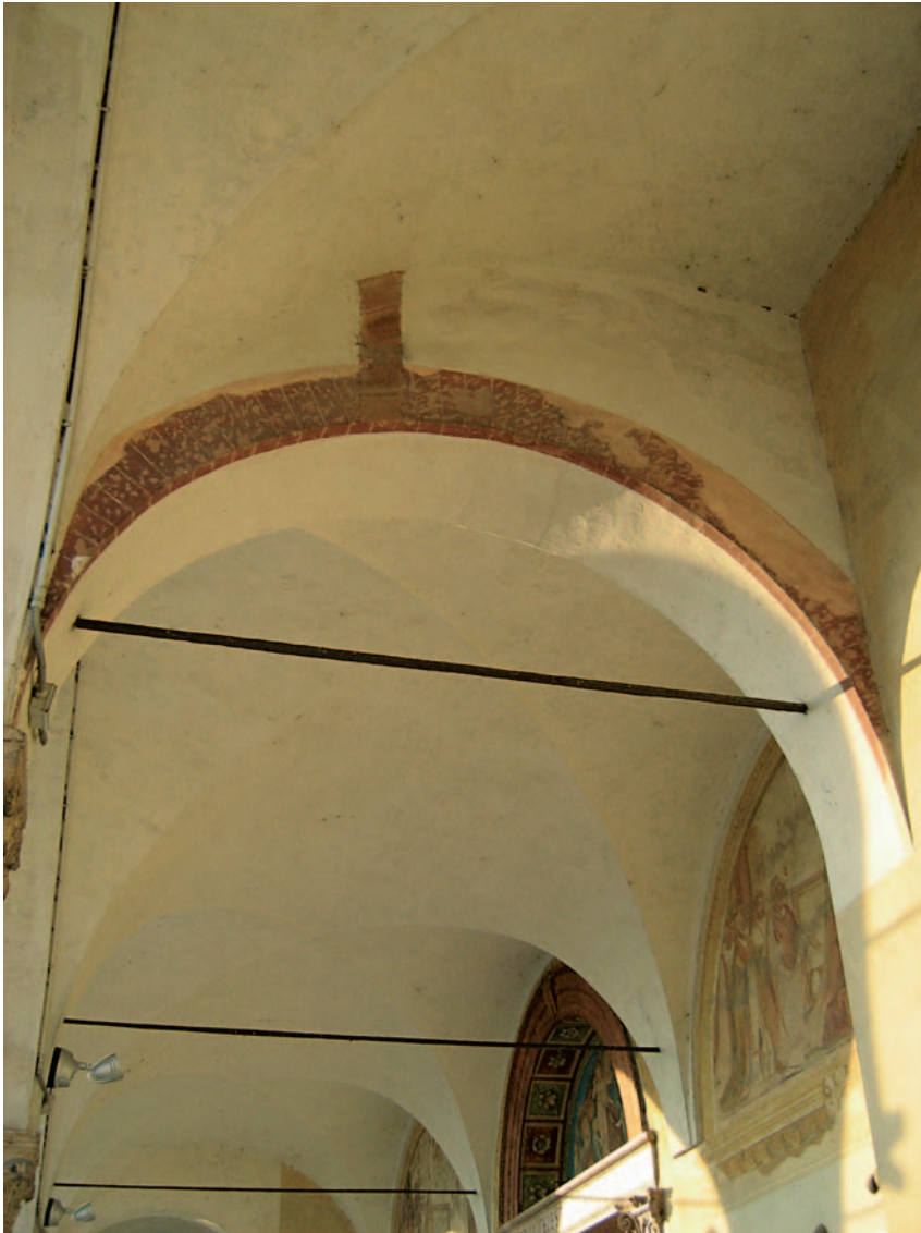
Fig. 18 - Innesto del portico al triforio centrale tra la settima e l'ottava lunetta. Si notino il contrafforte destro della facciata e l'arco d'innesto riportante tracce di decorazione a mattoncino e un sovrastante tassello con finte architetture.
