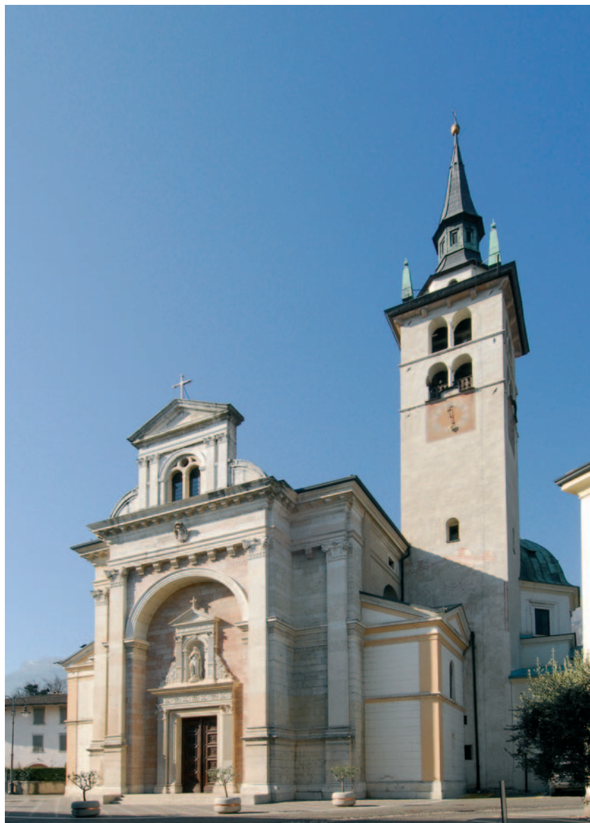
Fig. 36 - Villa Lagarina, Santa Maria Assunta, facciata (2008, FB).
