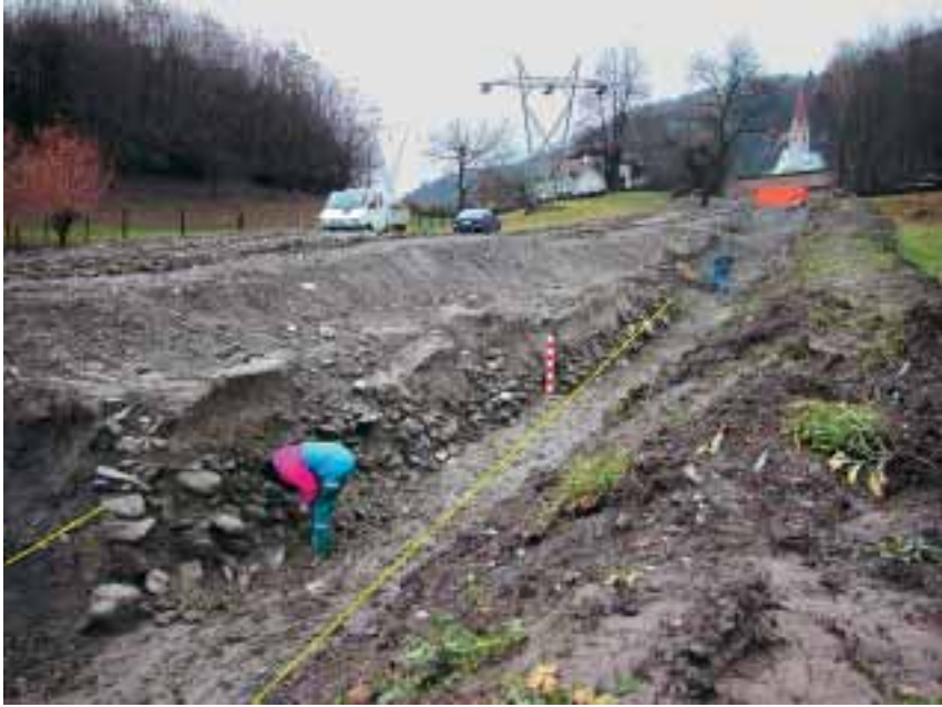
Fig. 10 - Tratto di strada antica posto in luce a Milland-Bressanone.
