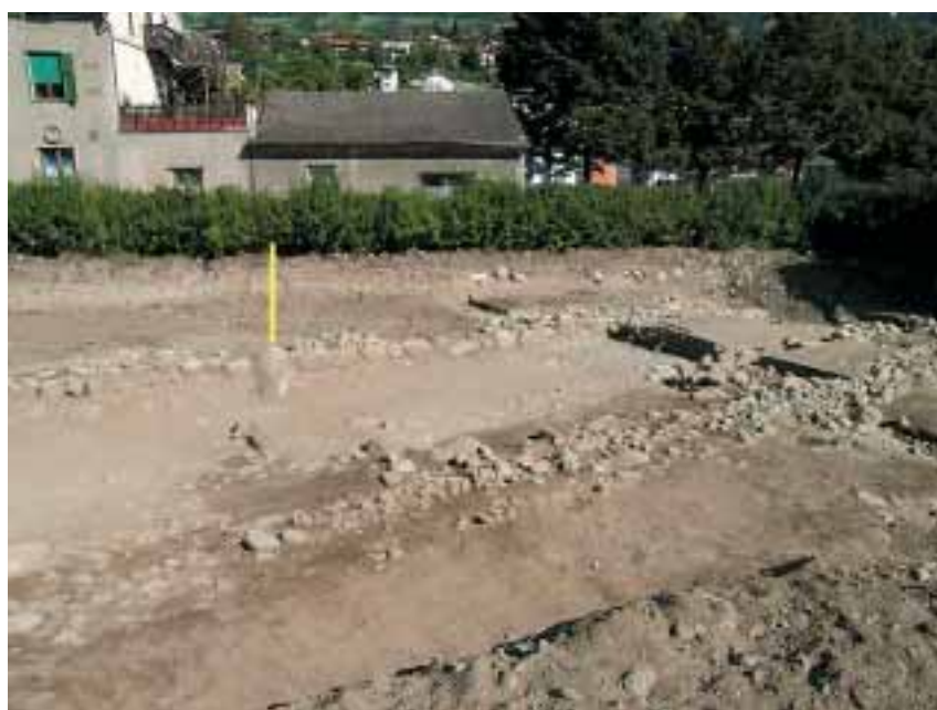
Fig. 18 - Cantiere «City Bau» a Rosslauf-Bressanone. Veduta laterale da Ovest.
