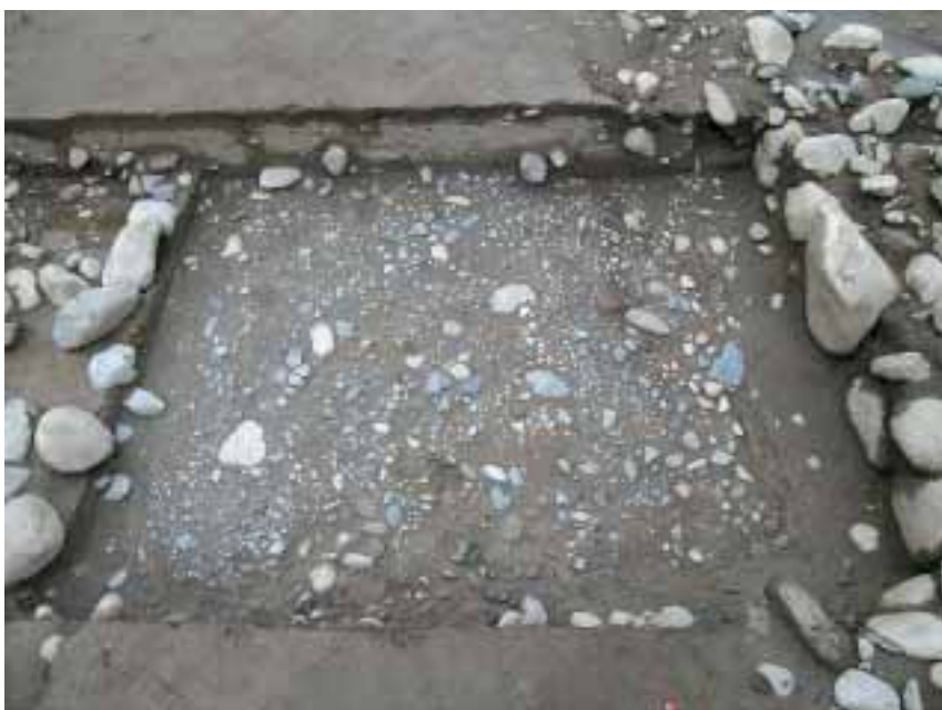
Fig. 16 - Cantiere «City Bau» a Rosslauf-Bressanone. Consolidamento di base.
