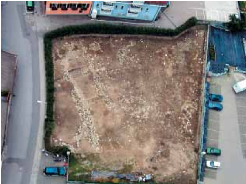
Fig. 15 - Cantiere «City Bau» a Rosslauf-Bressanone. Veduta aerea da Nord.
