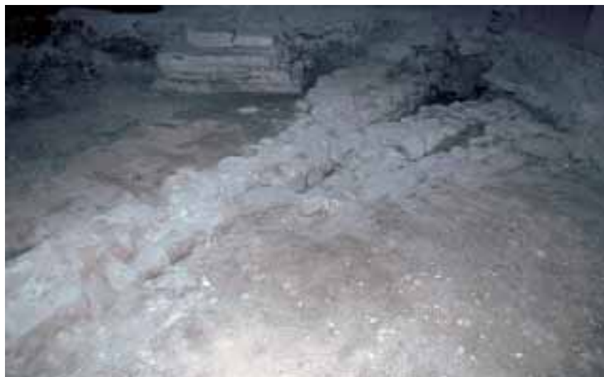
Fig. 16 - Transetto sud: murature attribuite a un terrazzamento ceduto e quindi risarcito. Sullo sfondo, la scaletta di accesso laterale all'abside seicentesca.
