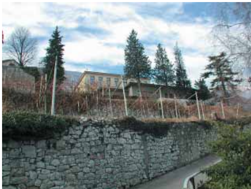
Fig. 3 - Le condizioni di abbandono dell'asilo dismesso e il sistema dei terrazzamenti.
