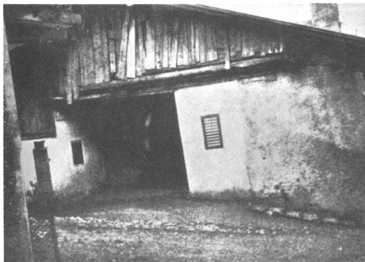
Fig. 31 - Abitazione di Tesero del sec. XVII (via Cavada, 16), in cui è visibile un ambiente (atrio) sprovvisto di parete verso l'esterno. Secondo G. Tosi (1971) l'ambiente B della casa occidentale dei prati del Zelòr può aver avuto un'analogha funzione. (Foto B. Sala).
