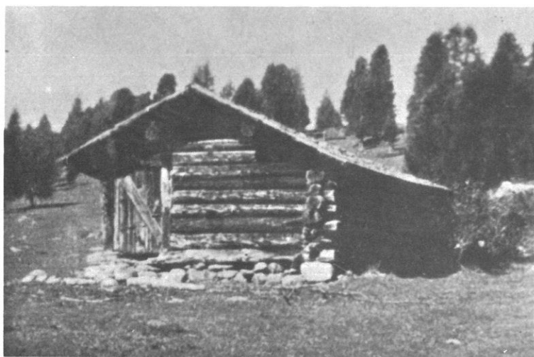
Fig. 50 - Questo «baito» tra il Passo degli Occlini e Redagno ( Radein ) può dare un'idea delle abitazioni a un solo vano del Doss Zelòr con la base in muratura a secco e la sovrastruttura lignea. (Foto P. Leonardi).
