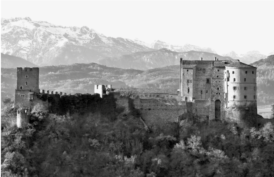
8. Castel Pergine, prospetto sud-est visto da località Valar.
