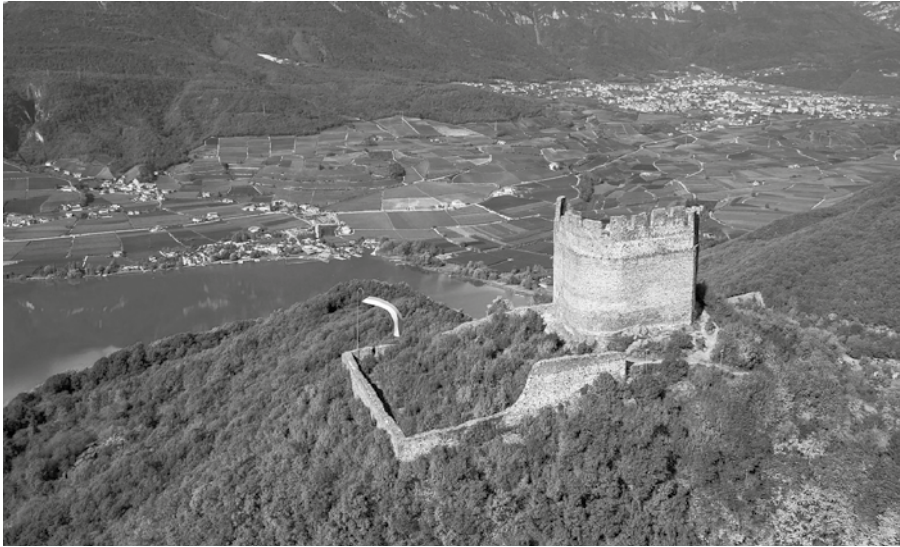
6. Castelchiaro (Leuchtenburg) nei pressi di Caldaro sulla Strada del Vino, prospetto est.
