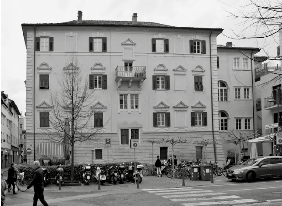
1. Bolzano, casa Schrofenstein vista da sud est.
