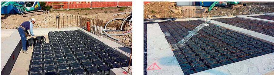
19-20. Esempio di costruzione di un nuovo edificio con accorgimenti anti radon: messa in opera di vespaio igloo con aerazione e guaina d'isolamento.
